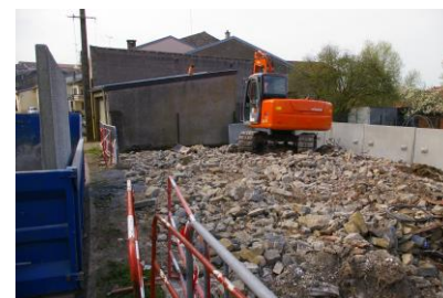
Le parking rue de Benney progresse
