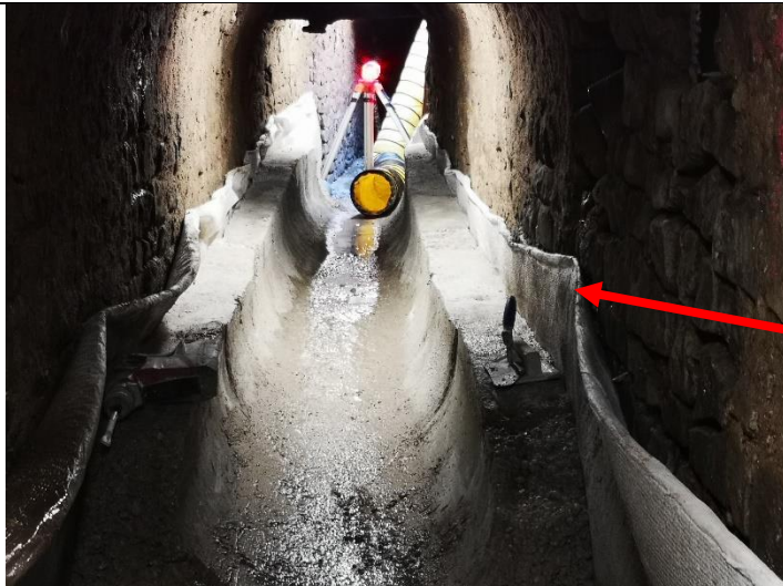
Réalisation de la cunette.
