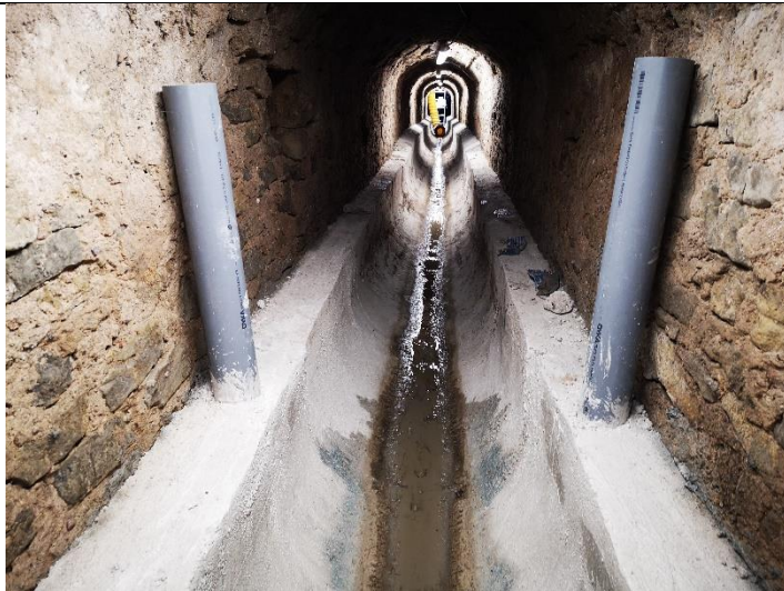
Réalisation de la cunette en cours avec remontée des.
